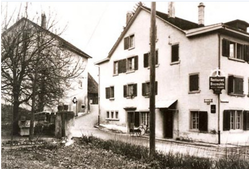
Rest. Binzmühle, 8050 Zürich (ca. 1960)
